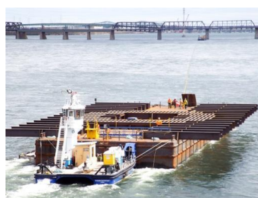
Transport d'équipements surdimensionnés : morceaux du nouveau Pont Champlain
